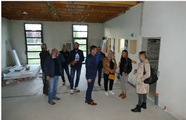
Chantier : les élus dans le futur restaurant scolaire
