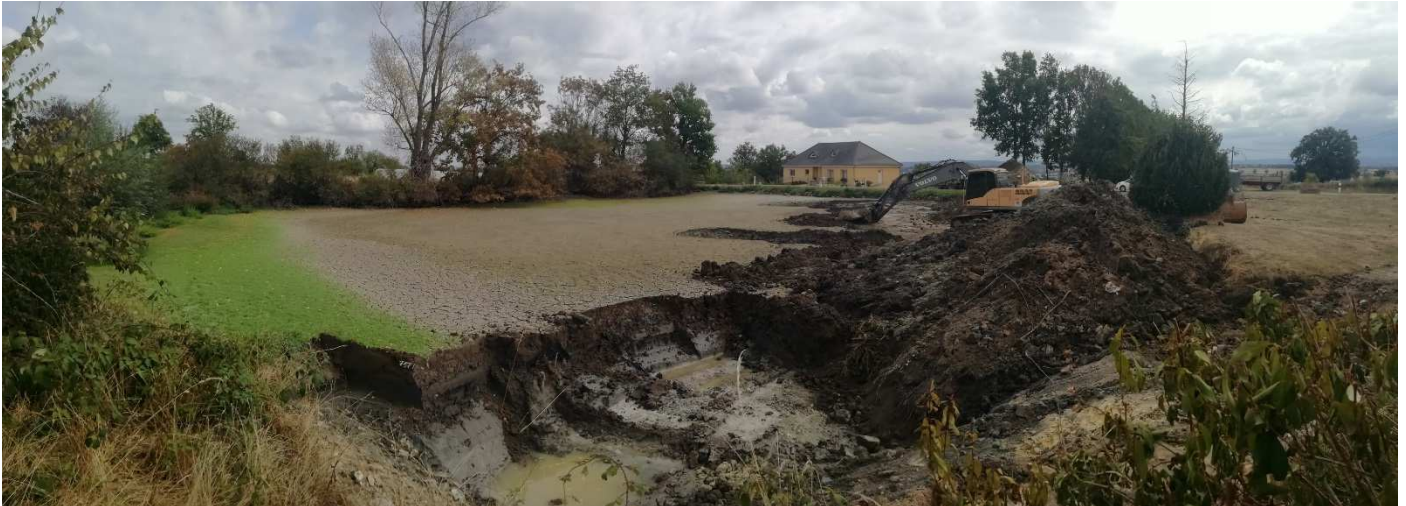
Mare des Theix – Travaux stoppés en raison de l'arrivée de la pluie
