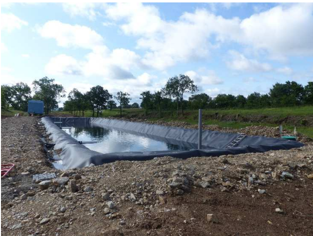
Pose de la géomembrane
