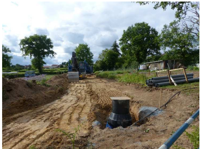
réhabilitation du réseau
